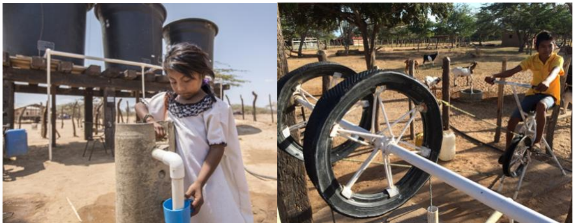
Sistemas de bombeo solar y mecánicamente asistido para comunidades de la Guajira media.
