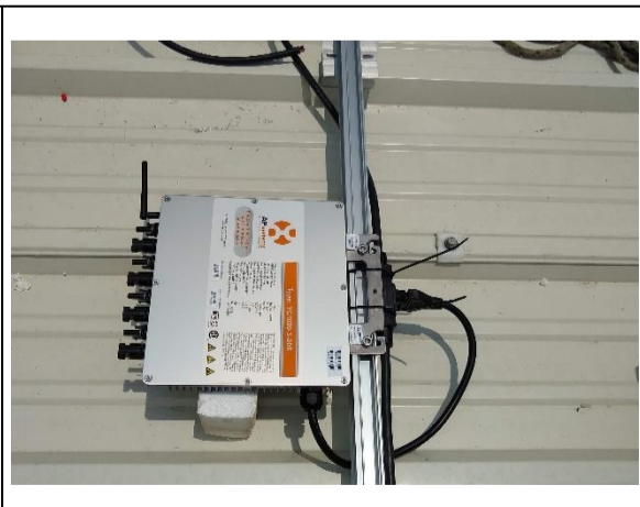
2.3 KWp con micro inversores
