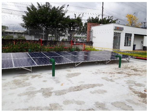
Instalación sobre losa en estructura de aluminio
