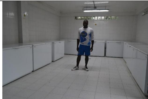
Batería de refrigeradores solares refrigeración de pescado, Cajambre, Valle, 10 KWp. Abr 2015.
