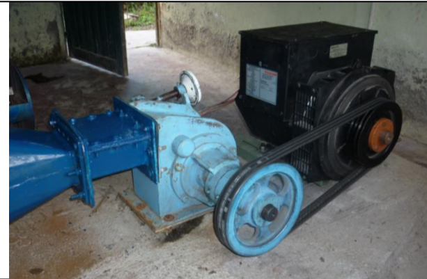
Turbina Hidráulica 10 KW en cabildo Indígena de Lame, etnia NASA, Tierradentro, Cauca, Febrero 2004
