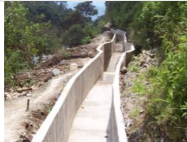
Diseño y gerencia de obra para la Rehabilitación de la PCH el Buco de 470 KW, Páez, Cauca
