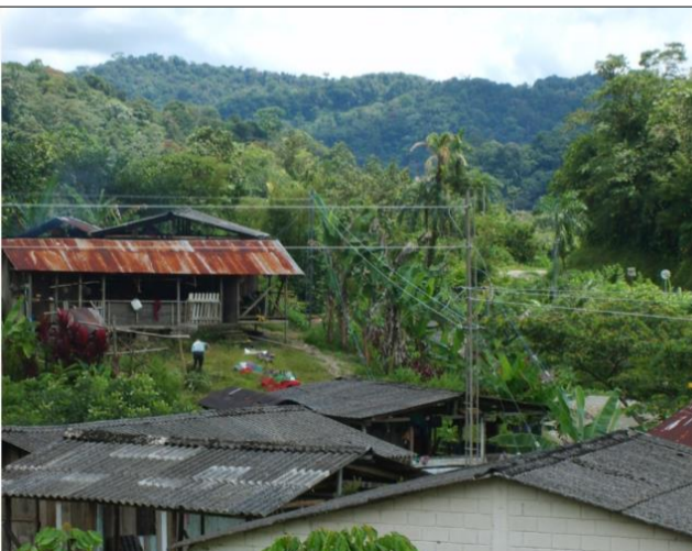
Energización vereda etnia Embera. 30 viviendas y centro comunitario
