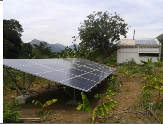
Sistema solar híbrido 12 KWp Puesto de Salud IPS GONAWINDUA
