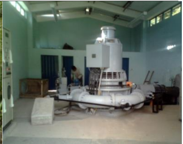
Instalación de turbina pelton de eje vertical, y reconstrucción de obra civil. Sept 2008
