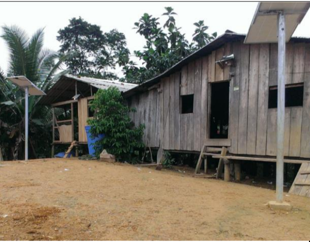
Instalación sistemas fotovoltaicos unifamiliares para 200 familias
