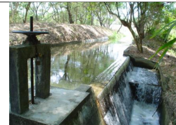
Agropecuaria Pajonales S.A. 20 KW para piscícola
