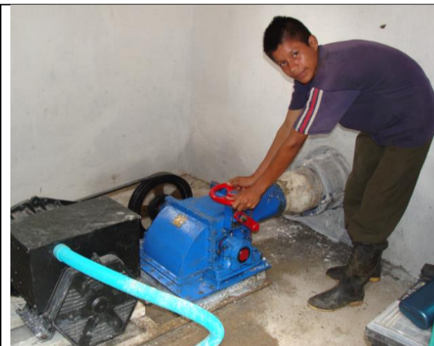
Sector 18, Vía Medellín – Quibdó. Turbina hidráulica de 10 KW de potencia Agosto 2008
