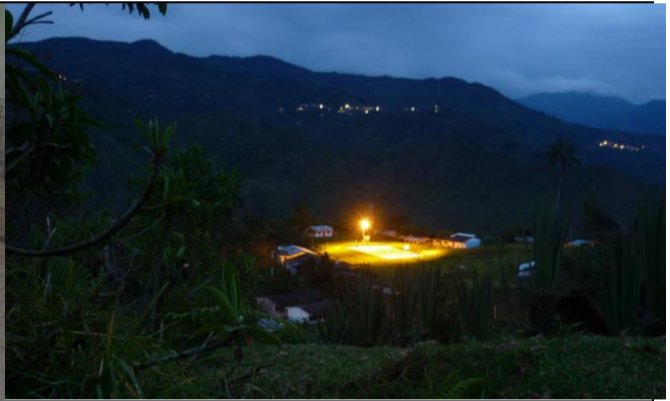
Energización de vereda LAME. 1.4 km de redes de interconexión en media tensión. 35 viviendas, 200 beneficiarios
