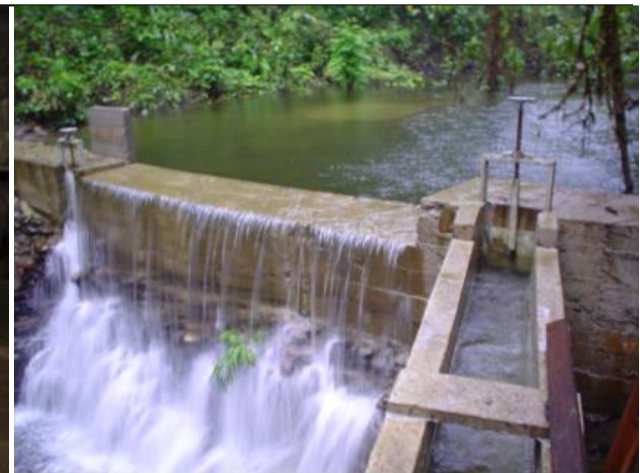
Turbina hidráulica de 30 KW para energización de 150 viviendas, comunidad afro.
