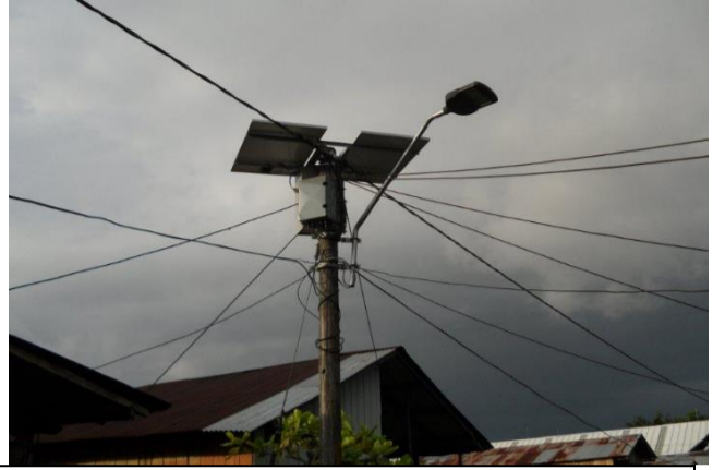
Instalación de 125 luminarias led para iluminación pública. Gobernación Antioquia, Agosto de 2016
